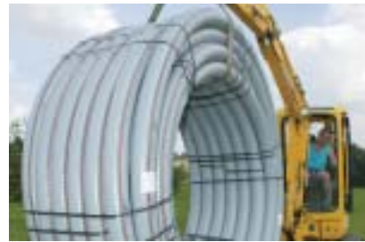
Obr. 38: Přeprava potrubí RAUTHERMEX
