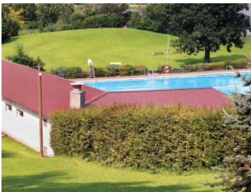
Obr. 3: Potrubí na topnou vodu pro vytápění bazénu
